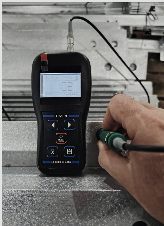
— Контроль толщины цинкового покрытия толщиномером ТМ-4
