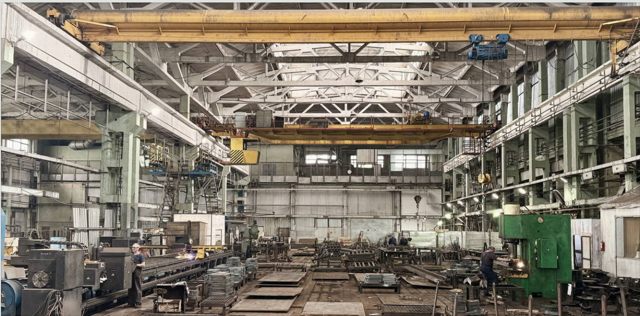
Пролёт цеха с мостовыми кранами
